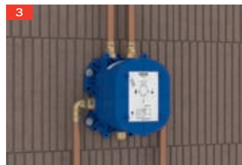
3 Připojte a zaizolujte trubky Zkontrolujte připojení Důkladně propláchněte trubky
