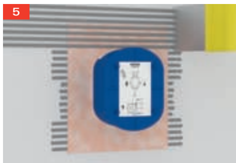
5 Naneste na stěnu lepidlo na obklady Osadte podkladní materiál pro utěsnění stěny a naneste na něj lepidlo na obklady
